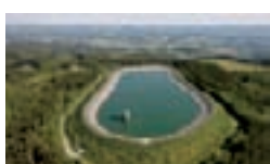
Glingebachtalsperre Pumpspeicherwerk Rönkhausen 132 - 137
