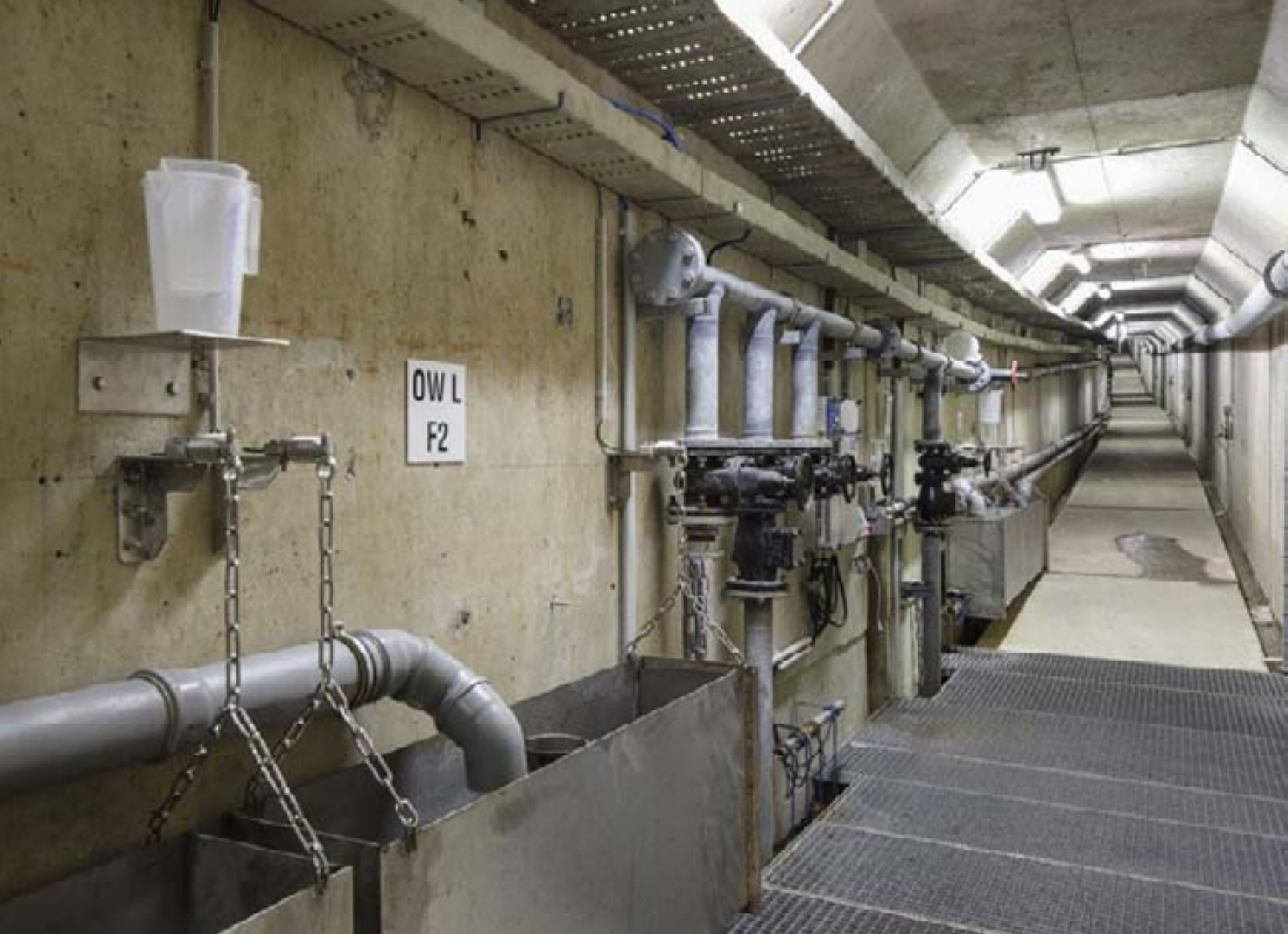
Kontrollgang der Wupper-Talsperre
