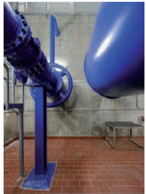
Über den Grundablass mit Kegelstrahlschieber und Ringkolbenventil kann der Stauinhalt entleert werden.
